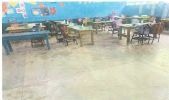
Foto 1: Sustitución de piso de torta de concreto por encontrarse deteriorada por piso cerámico de tres aulas.
