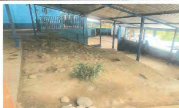
Foto 4: Reparación del área de gradas de acceso de tres módulos, debido a la limitación de espacios de accesos dentro del centro educativo.
