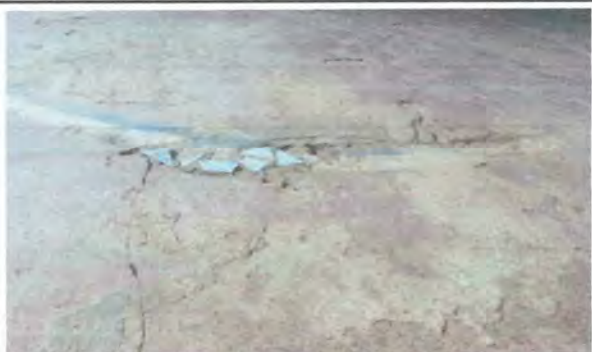
Foto 3: Reparación de las planchas de concreto del patio principal, debido que el centro educativo no cuenta con espacio de recreación para los alumnos.
